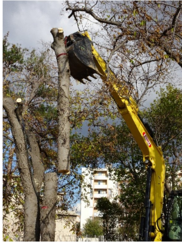
Figure 1: Abatage avec rétention (source Egis)
